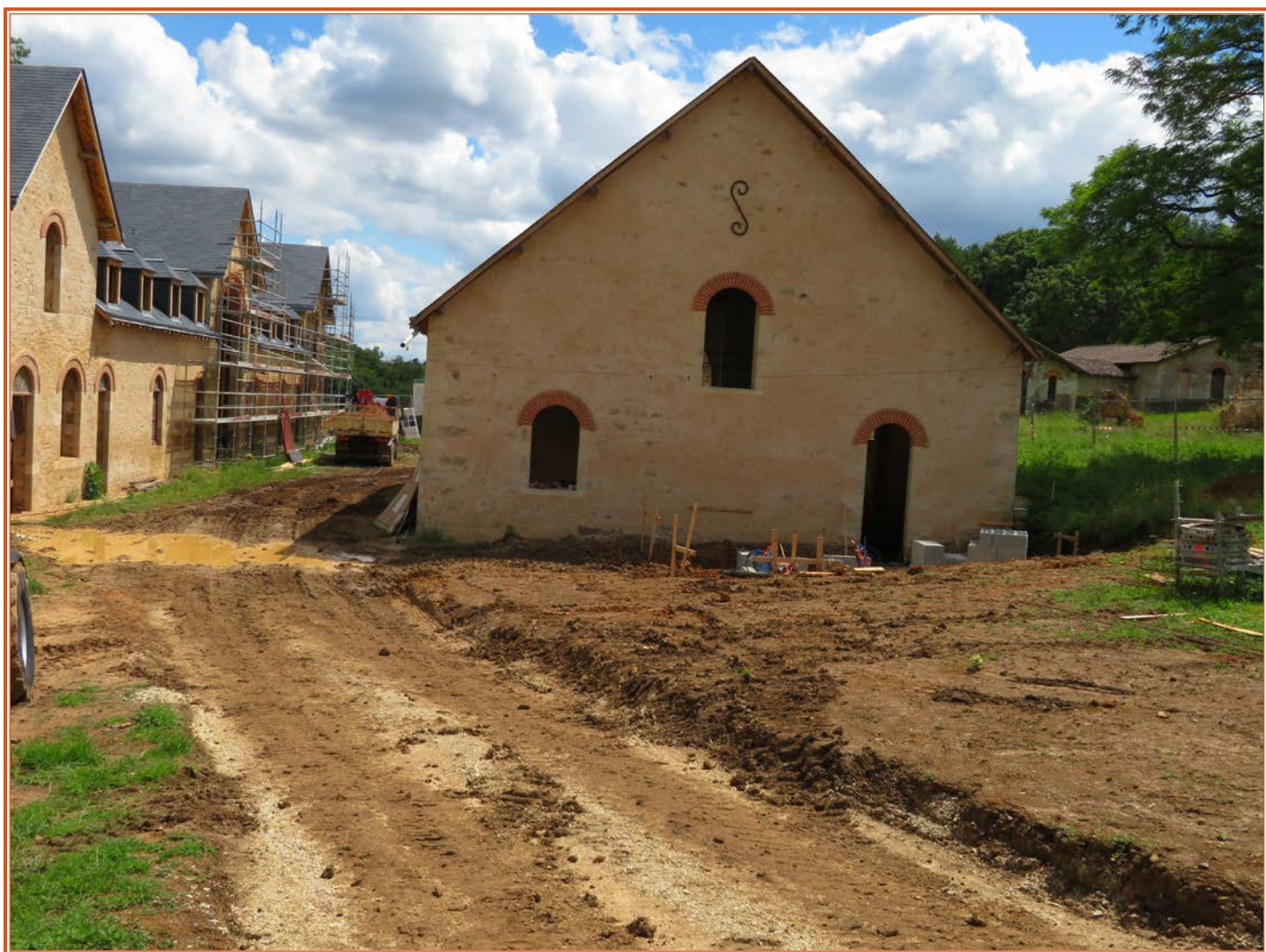
Rénovations de Bonnevaux.
